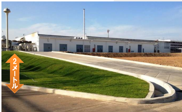
ユーティリティー棟(ナワナコーン工場)
